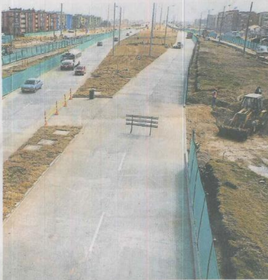
Críticos cuestionan desfinanciación de nuevas obras En la foto, la construcción de la troncal Américas.
