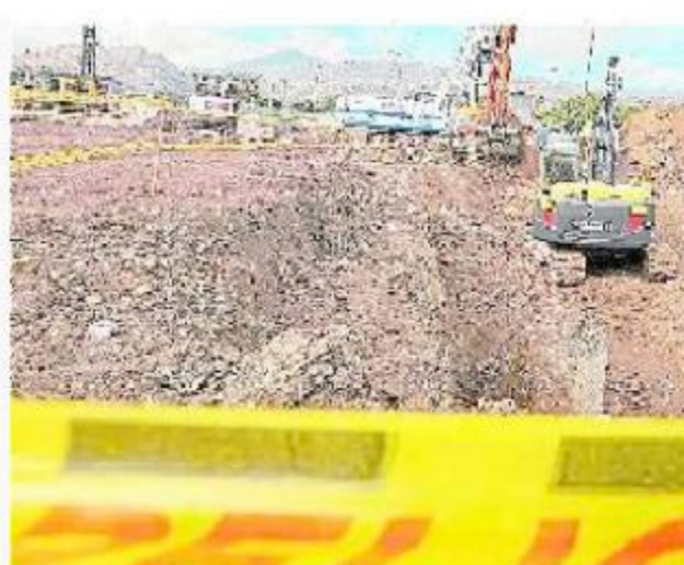
Foto: Mauricio Moreno En el portal El Tunal de TM ya están trabajando en la construcción
