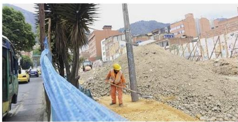
Las obras incluyen adecuación de andenes y andenes. Actualmente se interviene el costado sur.
