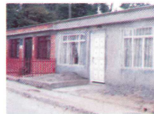
Reconstrucción de vivienda. Zona 13
