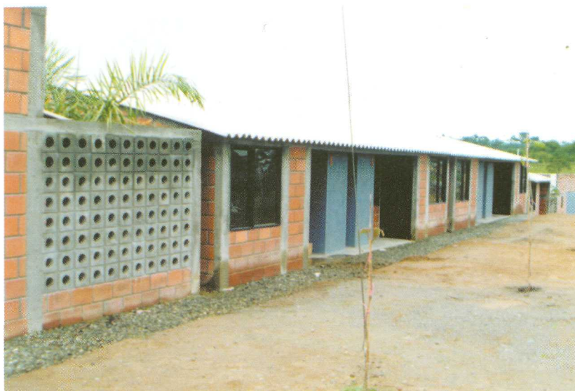
Panorámica de un grupo de viviendas entregadas por la Universidad Nacional de Colombia
