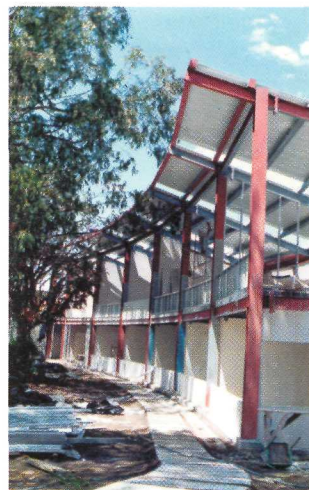
Colegio Jesús María Ocampo en etapa de construcción.
