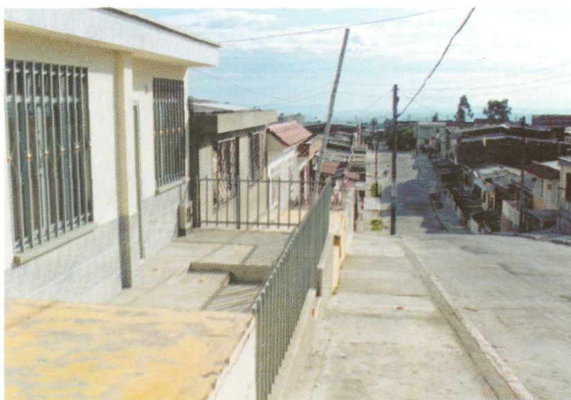
Barrio El Placer: viviendas reparadas.
